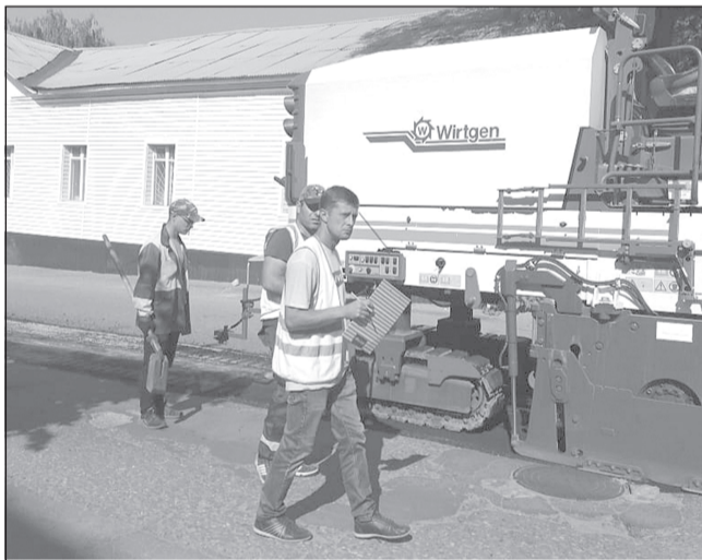
Идет фрезерование асфальто-бетонного покрытия дорожного полотна
